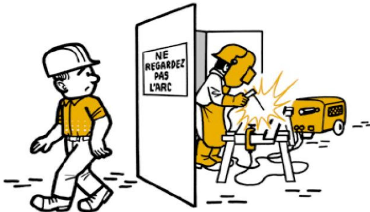
**Art. 225 modifié.** - Lorsque des travaux de soudage à l'arc sont effectués sur un chantier, des écrans doivent masquer les arcs aux personnes autres que les soudeurs ou leurs aides, afin de supprimer les risques d'éblouissement et les dangers de rayonnement ultraviolet. À défaut d'écrans protecteurs, les zones dangereuses doivent être délimitées et convenablement signalées.
